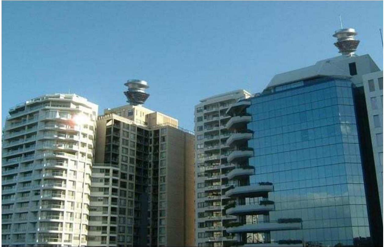
Figura 3. Sistema de energía renovable eólica IMPLUX
