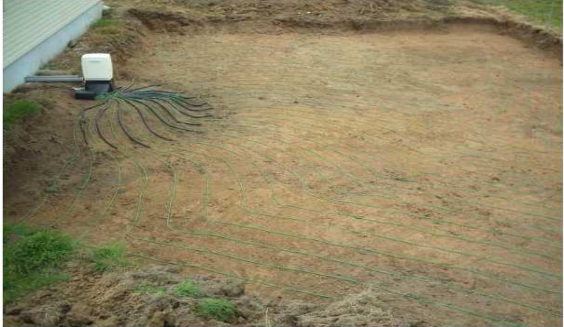
Figura 6. Instalación de geotermia con captación horizontal
