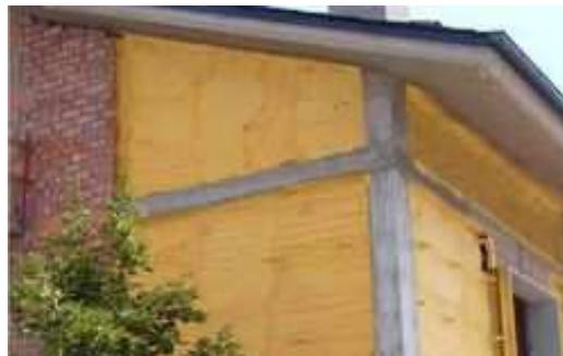
**Figura 5.** Aislamiento exterior de Poliuretano Proyectado
